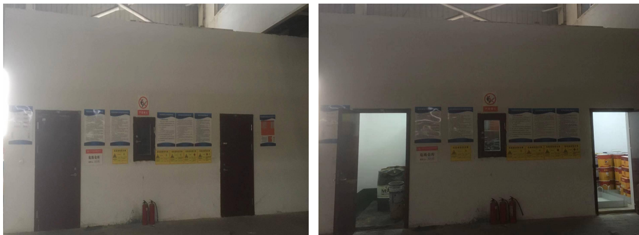
图 3-9 危险废物暂存间
