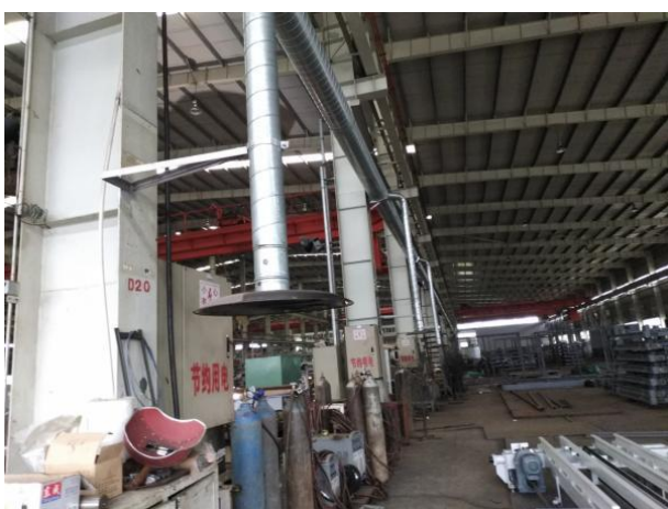
图 3-5 通风换气系统一套（内部换气管道）
