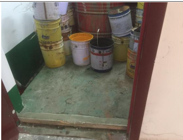
图 3-10 危废间门口设置围堰、内部设置导流沟
